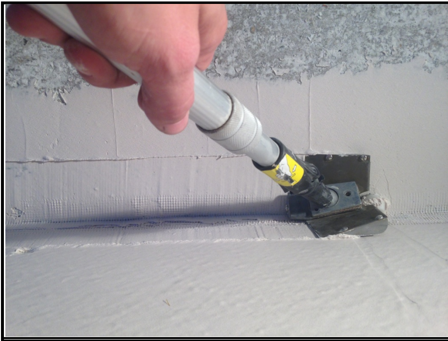
Figure 3 : Mise en place de la bande à joint autocollante pour la jonction mur/plafond
