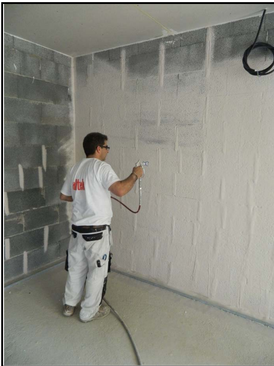
Figure 5 : Pulvérisation d'Alltek Spray Etanch'R
