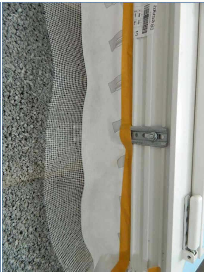
Figure 4 : Jonction des menuiseries- mise en œuvre de la bande Alltek Tape + Etanch'R avant application de l'enduit Etanch'R
