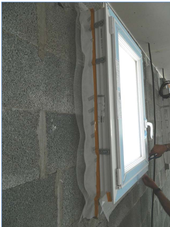
Figure 4 : Jonction des menuiseries- mise en œuvre de la bande Alltek Tape + Etanch'R avant application de l'enduit Etanch'R
